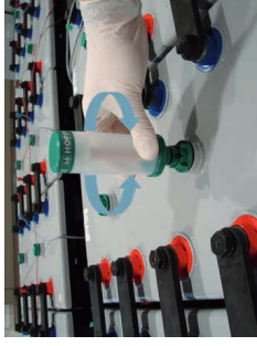
Abbildung 2: Einsetzen des AquaGen II
