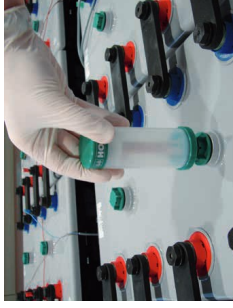
Abbildung 1: Einsetzen des AquaGen I
